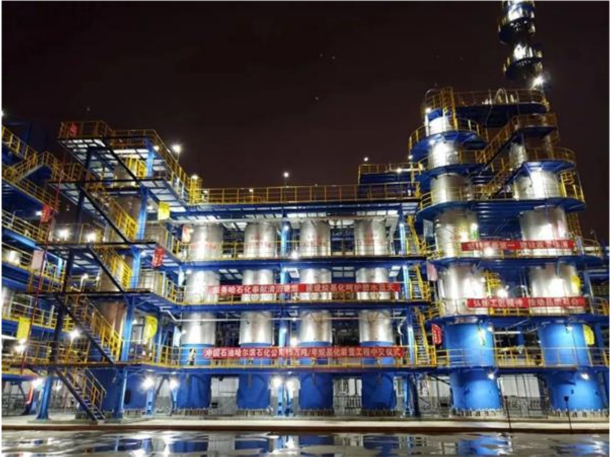
中国石油哈尔滨石化公司 15 万吨/年复合离子液体碳四烷基化装置
